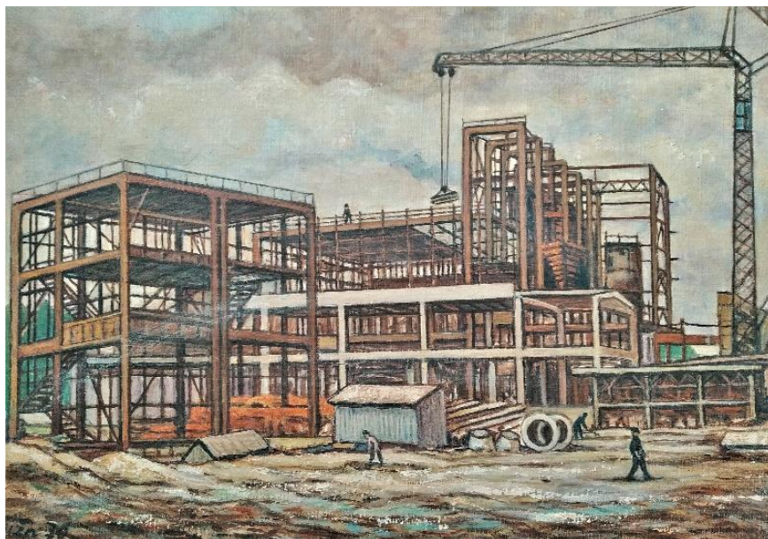
Kresba výstavby teplárny z roku 1970
